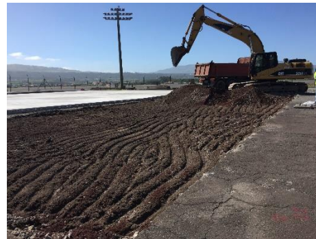
Figura 1 – Demolição do parque existente. Figure 1 – Demolition of the existing parking area.
