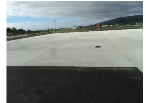
Figura 3 – Lajes em betão e pavimento betuminoso. Figure 3 – Concrete slabs and asphalt pavement.
