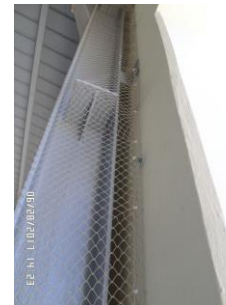
Figura 5 – Rede anti-pássaro. Figure 5 – Bird screening.
