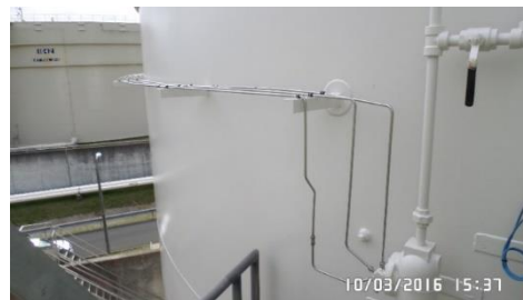
Figura 2 – Instalação de tubo da válvula de controlo de nível. Figure 2 – Installation of control tubing for the overfill valve.
