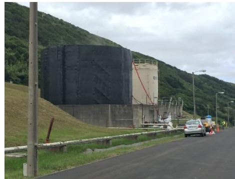
Figura 1 – Instalação de sistema de andaime. Figure 1 – Installation of a scaffolding system.
