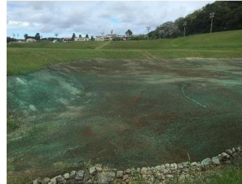
Figura 2 – Aplicação de hidrosementeira
