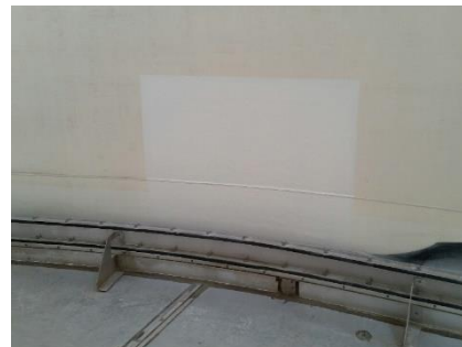
Figura 4 – Reparações da pintura pontuais.
