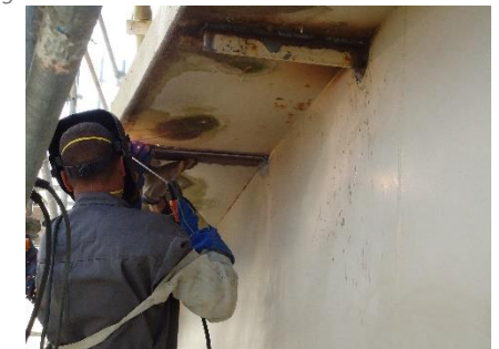
Figura 6 – Reparação dos anéis de reforço.
