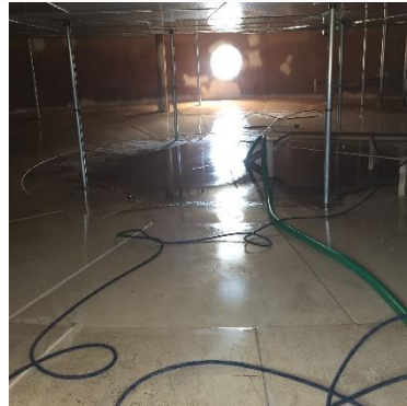
Figura 1 – Limpeza e desgaseificação de tanques.
