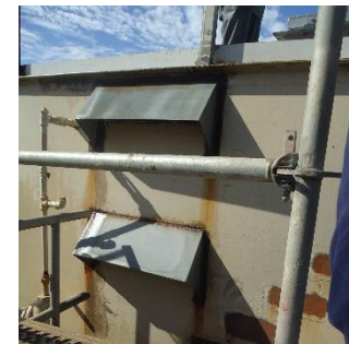
Figura 5 – Instalação de novos resguardos e grelhas anti-pássaro.
