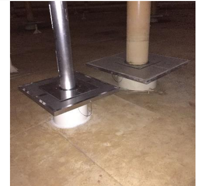
Figura 3 – Instalação de novos vedantes das colunas.
