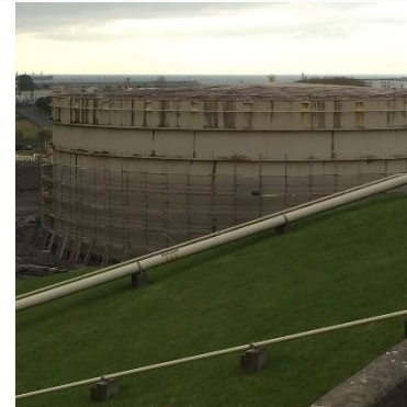
Figura 2 – Montagem e desmontagem de andaimes.
