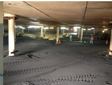
Figura 5 – Instalação do material de enchimento.
