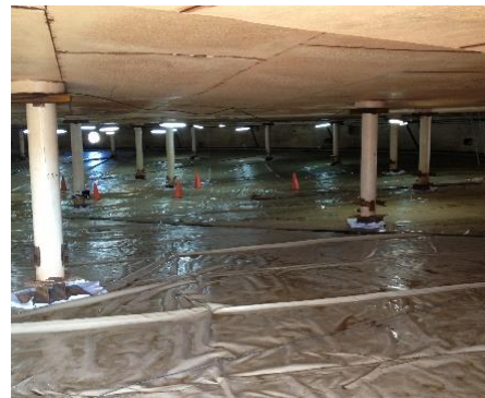
Figura 1 – Instalação de membrana no fundo.
