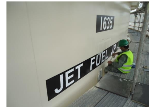
Figura 3 – Reparações de pintura no exterior.
