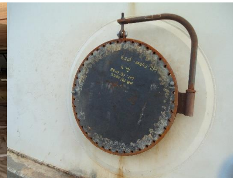
Figura 2 – Instalação de porta de homem.
