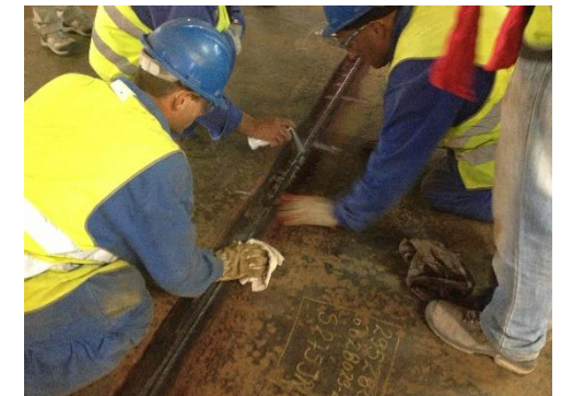
Figura 6 – Execução de testes às soldaduras.
