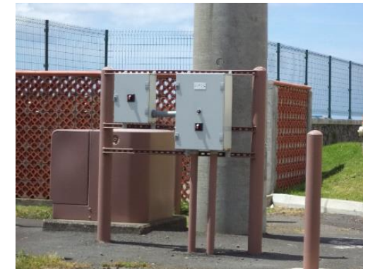
Figura 2 – Instalação de novos interruptores de desconexão, controladores e transformadores. Figure 2 – Installation of new disconnect switch, controllers and transformer.
