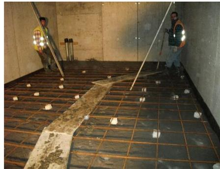
Figura 1 e 2 – Execução de pavimento em betão.
