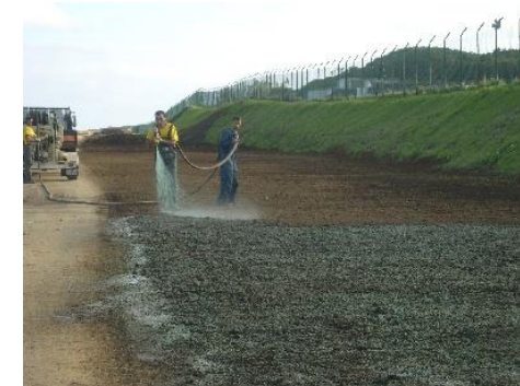
Figura 2 – Execução de hidrosementeira. Figure 2 – Hydroseeding.
