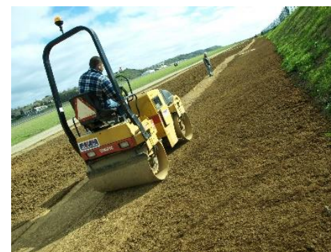
Figura 4 – Compactação do terreno. Figure 4 – Ground compaction.
