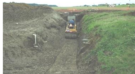
Figura 1 – Compactação de vala. Figure 1 – Trench compaction.
