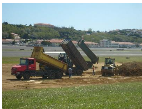
Figura 3 – Execução de aterro. Figure 3 – Backfill.
