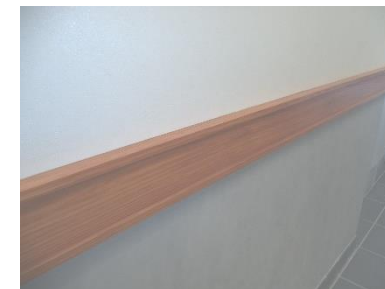
Figura 3 – Piso cerâmico e rodapé. Figure 3 – Ceramic tiles and wood covebase.
