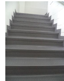
Figura 2 – Novo cerâmico instalado nas escadas. Figure 2 - New stairs ceramic tiles.
