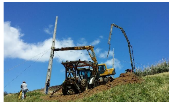
Figura 3 – Instalação de novos postes em betão.
