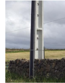
Figura 4 – Postes em betão instalados.
