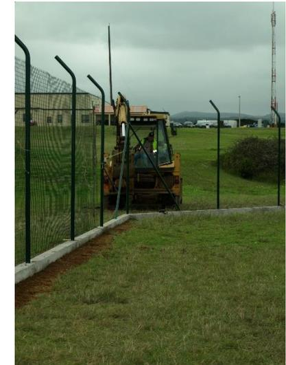
Figura 3 – Instalação de vedação de segurança.
