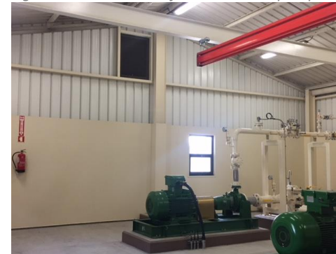
Figura 5 – Modificação do edifício para instalação de uma nova bomba. Figure 5 – Modification of the building to accommodate the new pump.
