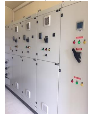
Figura 4 – Instalação de interruptor de transferência manual e nova secção MCC. Figure 4 – Installation of a manual transfer switch and new MCC section.
