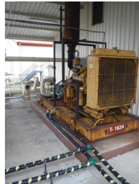
Figura 1 – Demolição de bombas existentes. Figure 1 – Demolition of existing pumps.
