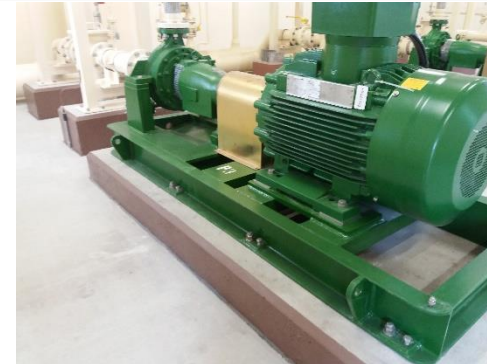
Figura 2 – Instalação de bomba elétrica. Figure 2 – Installation of new electrical pump.
