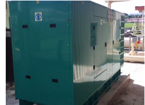
Figura 3 – Instalação de gerador. Figure 3 – Installation of a generator.
